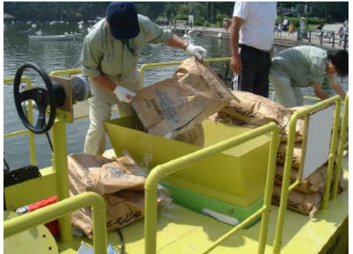
環境改善剤をホッパーに投入
