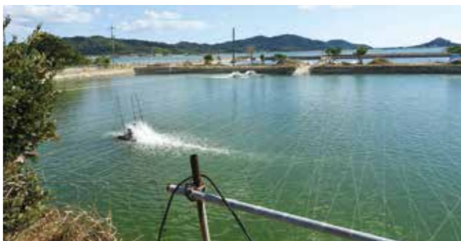
秋穂における素掘りの築堤式養殖池。写真は旭水産の第1池で、広さは5,600㎡。水深は1.8～2.0m、水温は冬6℃、夏34℃である。水面上2mほどの位置に防鳥対策としてテグスを張っている。
