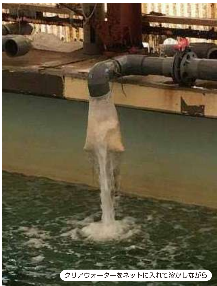
クリアウォーター散布の様子
