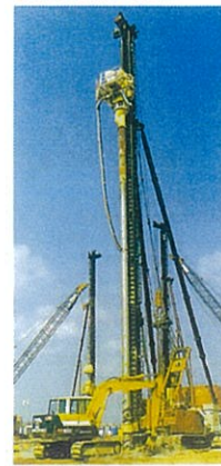
【石灰パイル工法】
