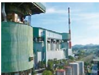
①焼成設備 (宇部ベッケンバッハ式 堅型焼成炉) 原料である石灰石を 900℃以上で焼成し生石 灰を生産する設備
