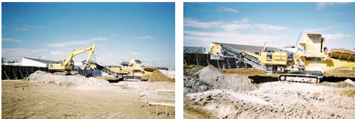
【酸化マグネシウムによるフッ素汚染土壌不溶化処理工事の様子】
