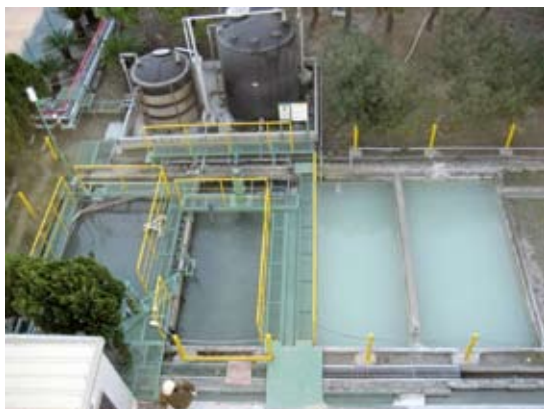
排水 pH 処理施設
