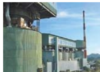
焼成設備 (宇部ベッケンバツハ式縦型焼成炉) 原料である石灰石を900℃以上で焼成し生石灰を生産する設備
