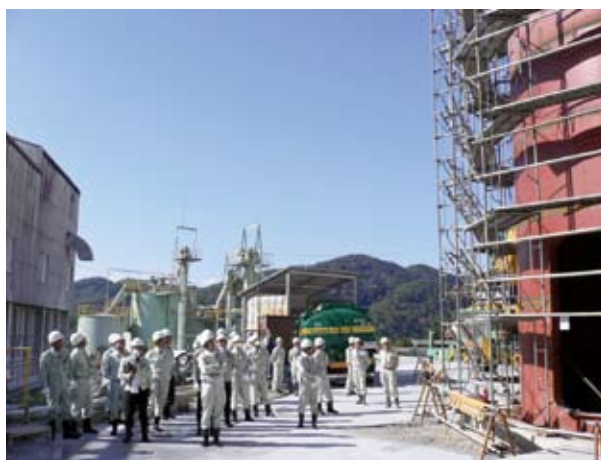
製品タンク新設工事現場の視察（東北鉄興社）
