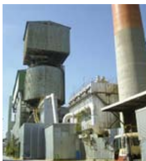
排ガス用大型集塵機 3基
