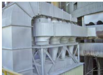
サイクロン集塵機（複列） 8基
