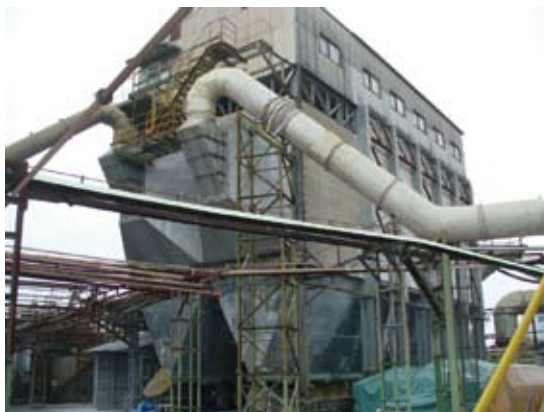
キルン排ガスの電気集塵機（9基）
