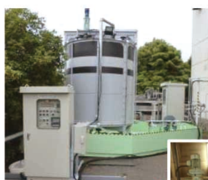
水酸化マグネシウム貯槽
